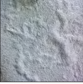
Alt yüzeyde nem olması sebebiyle oluşan kabarma
